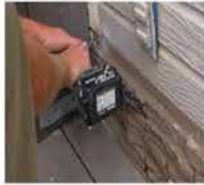
3. Install the first panel from the left bottom. 从墙底左侧开始安装第一块板
